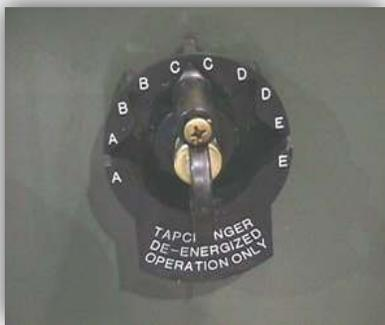
Figure 2 – Cambiador de derivaciones rotatorio
